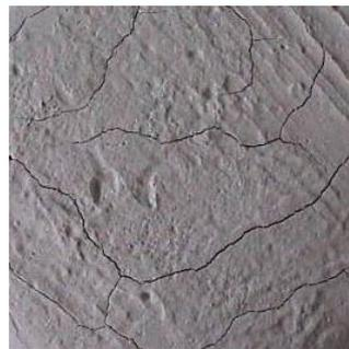
❖ 为网状干缩性裂纹，是因石灰砂浆在硬化过程中干燥收缩所致。尤其是水灰比过大，石灰过多，易产生此类裂纹
