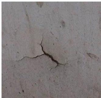
❖ 为凸出放射性裂纹，这是由于石灰浆的陈伏时间不足，致使其中部分过火石灰在石灰砂浆制作时尚未水化，导致在硬化的石灰砂浆中继续水化成  $\text{Ca}(\text{OH})_2$ ，产生体积膨胀，从而形成膨胀性裂纹
