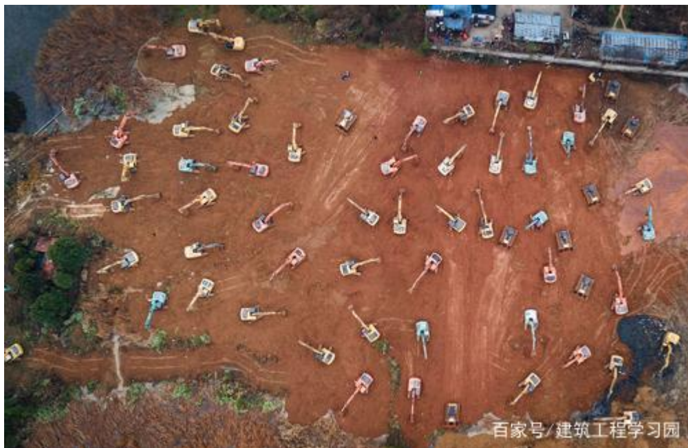
火神山建设航拍图
